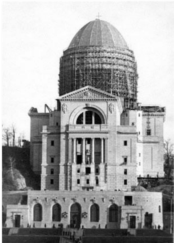
Le dôme de l'Oratoire en cours de construction
